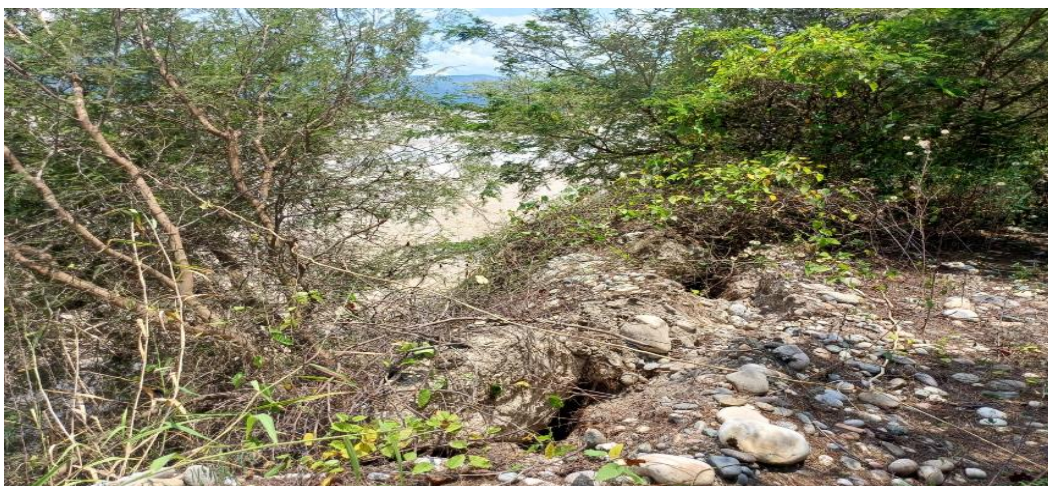
FIGURA N°02: DESPRENDIMIENTO DE ROCAS EXISTENTES COMO DEFENSA POR ACCION EROSIVA
